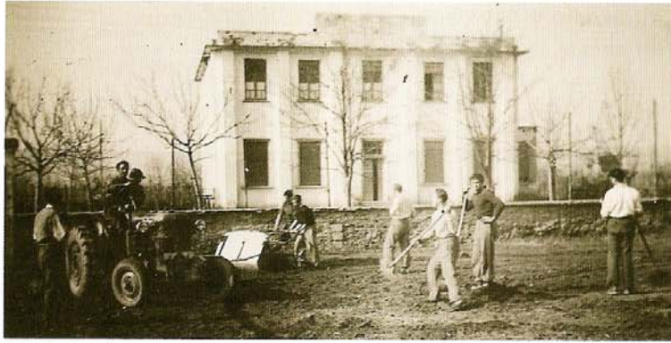
1949. Lavori per il campo sportivo - Archivio Plebani Ugo
